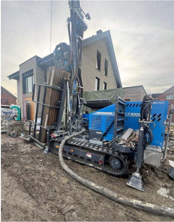
Bohrung und Einbau Sole-Wasser-Wärmepumpe
