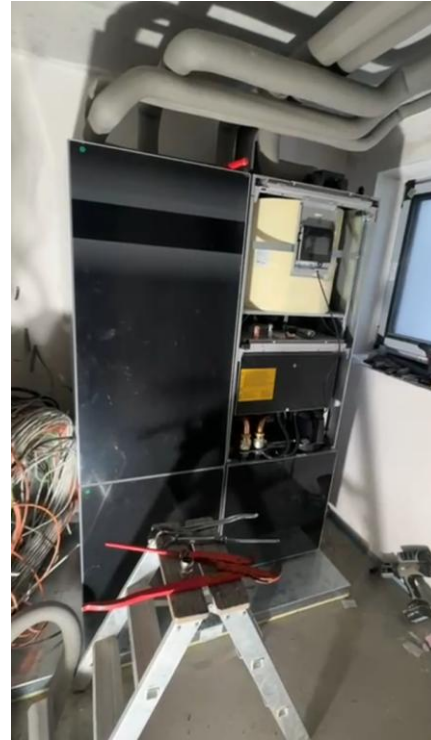
Bohrung und Einbau Sole-Wasser-Wärmepumpe
