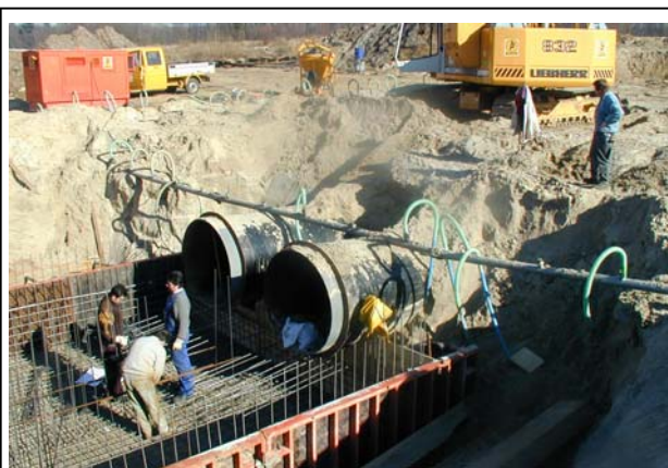
Bewehrungsarbeiten für die Stahlbetonsohle des Auslaufbauwerks
