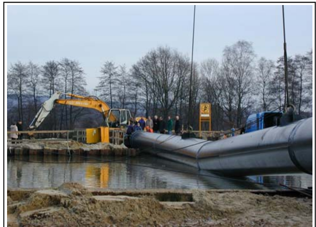
Einheben der Rohre des Schmiemann-Dükers
