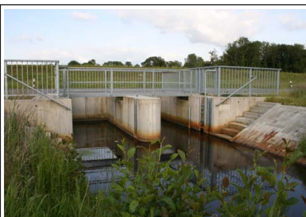
Fertiges Auslaufbauwerk des Schmiemann-Dükers
