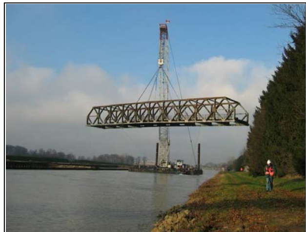
Die alte Birgter Brücke am Haken des größten kanalgängigen Schwimmkranes „Atlas“ während ihres Abbruchs im Januar 2004 Foto: Hahn
