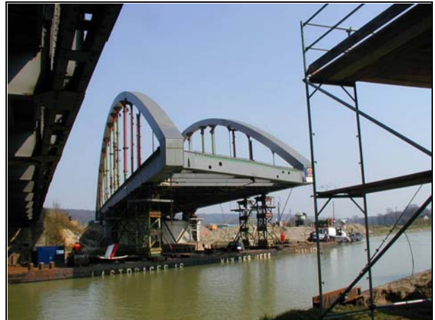
Moment der Lastübernahme durch ein im Kanal liegendes Ponton beim Einschwimmvorgang der Birgter Brücke im April 2003 Foto: Hahn
