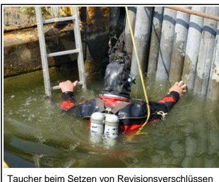
Taucher beim Setzen von Revisionsverschlüssen
